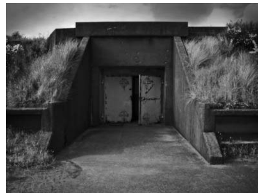
David Bardes, Bunker Door
